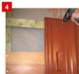
4 Die Alu-Solar-Trägerpfanne mit den beigelegten Edelstahlschrauben an der Traglatte befestigen.
