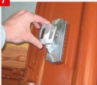
Anschließend den montierten Solarträgeraufsatz nach Dachneigung ausrichten.
