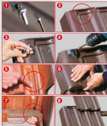
1. Gehören zur Lieferung jedes linken Ortgangziegels: Klammer, Dübel SX 5 und Kreuzschlitzschraube VA 3,5 x 25 mm (komplett vormontiert); Holzschraube VA 4,5 x 45 mm zur Ortgangbefestigung.
