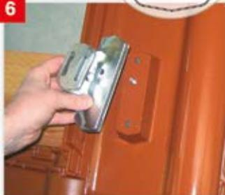
Jetzt kann der Solarträgeraufsatz mit der Trägerpfanne verschraubt werden.
