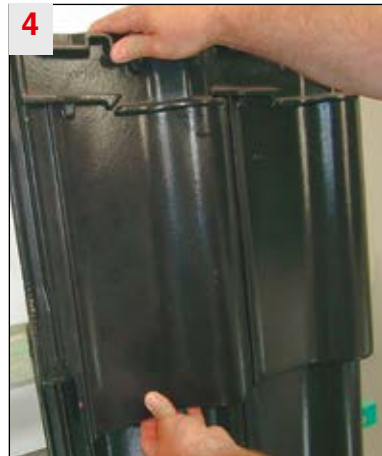
4 Dachziegel eindecken und andrücken. Fertig!
