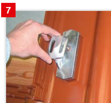
7 Anschließend den montierten Solarträgeraufsatz nach Dachneigung ausrichten.
