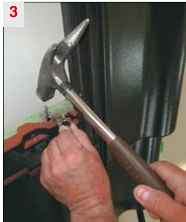
3 ... und von oben in die Traglattung einschlagen.
