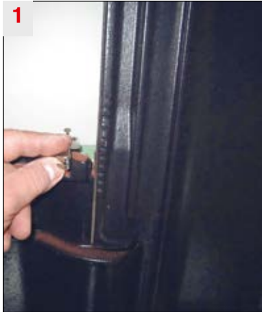
1 Multi-Sturmkralle über den Kopfalz...
