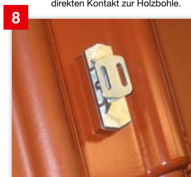
8 Das war's schon! Jetzt ist die Alu-Solar-Trägerpfanne für die unterschiedlichen Energie-Dachsysteme vorbereitet.
