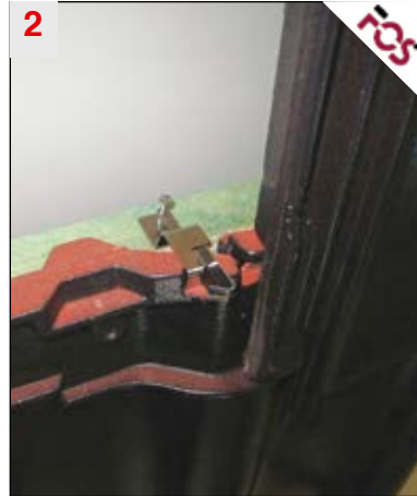
2 ... an der vorgesehenen Vertiefung positionieren...
