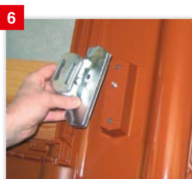
6 Jetzt kann der Solarträgeraufsatz mit der Trägerpfanne verschraubt werden.
