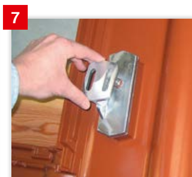
7 Anschließend den montierten Solarträgeraufsatz nach Dachneigung ausrichten.
